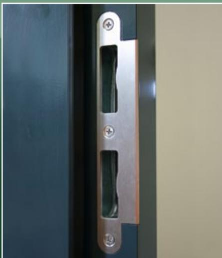
eingefrästes Schließblech stumpf
